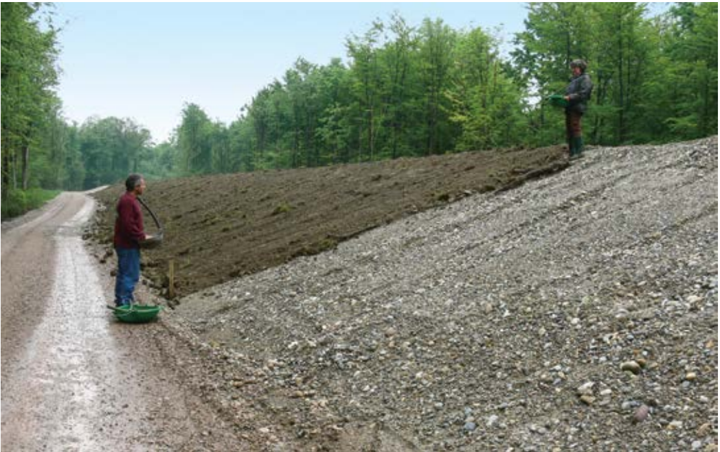
Abbildung 5: Handansaat auf krümelrauem Oberboden im Bereich des ertüchtigten Hochwasserschutzdamms V bei Rheinhausen im Jahr 2010. Dem Oberboden wurde zuvor ein Gemisch aus übertragenen Grassoden beigemischt.
