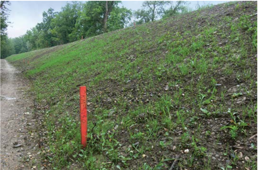
Abbildung 12: Frisch aufwachsende, gebietsheimische Begrünung auf der neu angelegten Dammoberfläche des Hochwasserdamms V im Jahr 2009. Foto: Reinhold Treiber
